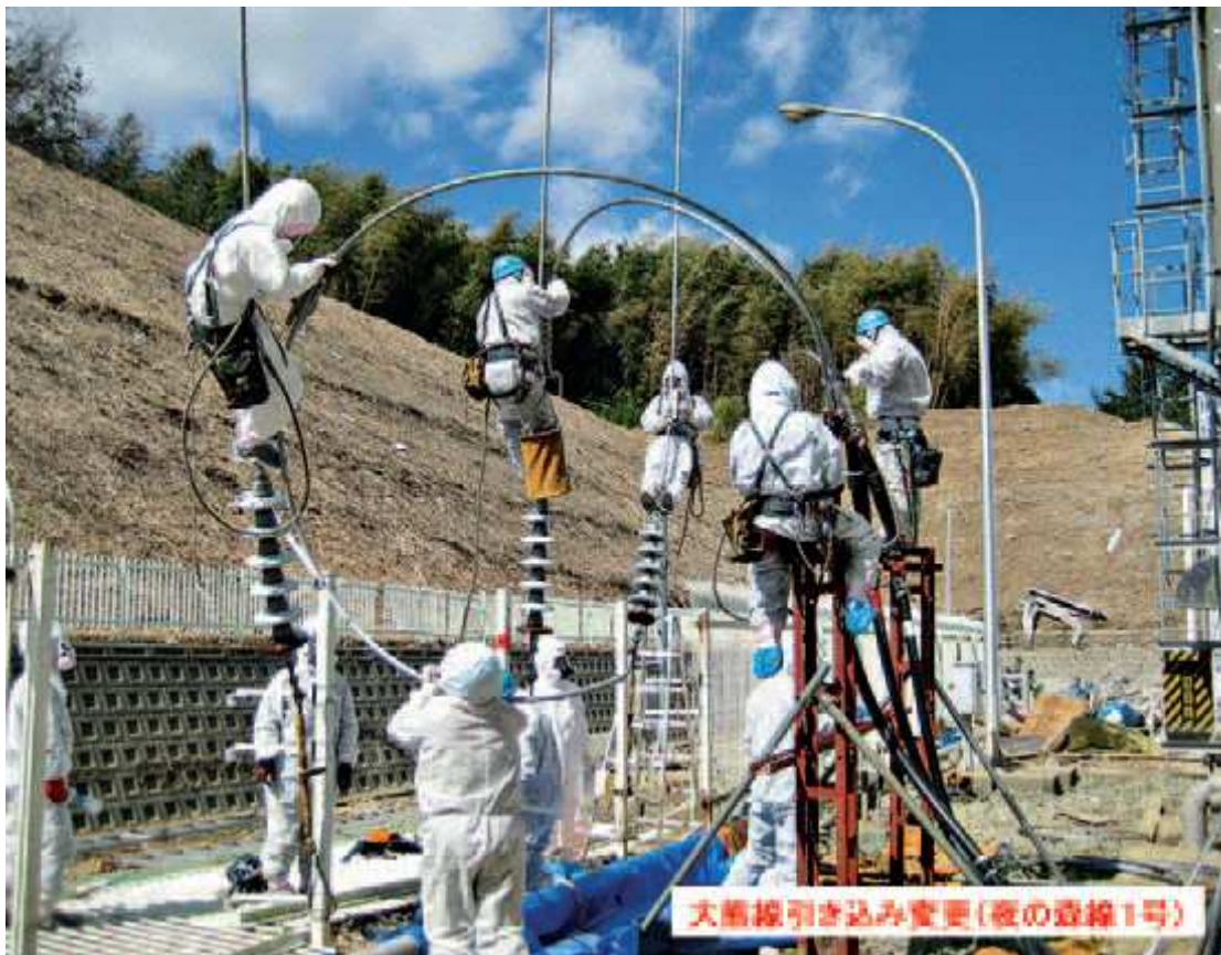
E) Arbeiten zur Wiederherstellung der Anbindung der Anlage an das Stromnetz (Quelle: TEPCO)
