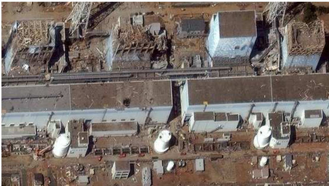
B) Die Anlage nach dem Unfall
