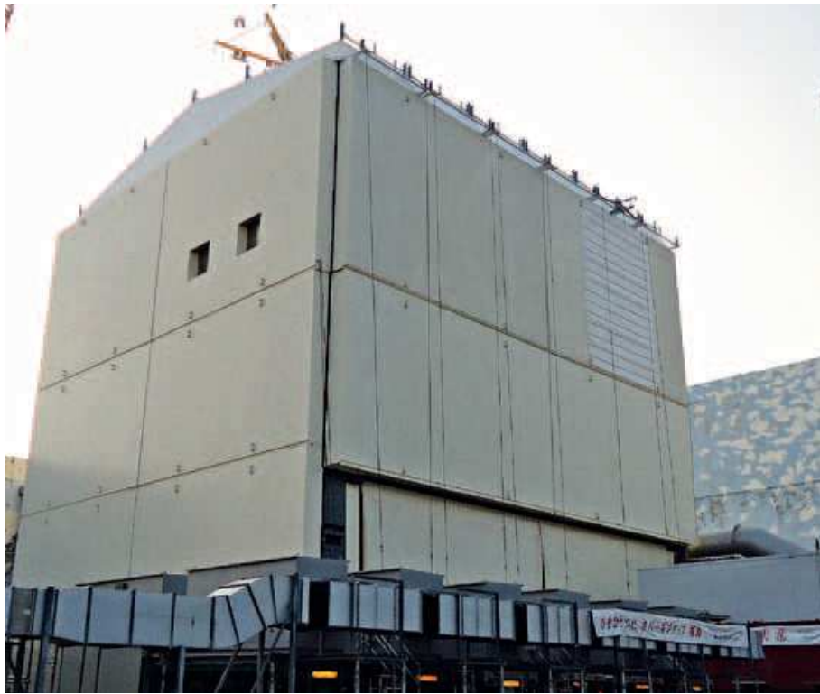
H) Errichtung der Einhausung um das Reaktorgebäude von Block 1 (Quelle: TEPCO)
